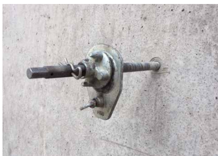
Anwendungsbeispiel: Abdichten des Bohrloches nach Einbringen eines Ankers | Exemple d'application: Etanchéité du trou de forage après l'insertion d'un ancrage
