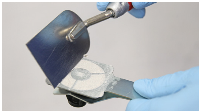
Appliquez la colle (Sikadur®-31+)
