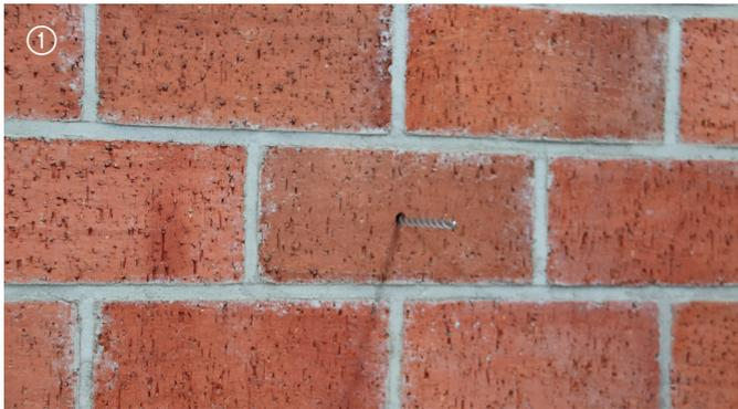
DESOI Anker Plus W laut Herstellerangaben einbringen. Um die Aufnahme anzubringen, muss der Anker Plus W mindestens 80 mm aus dem Mauerwerk ragen.
