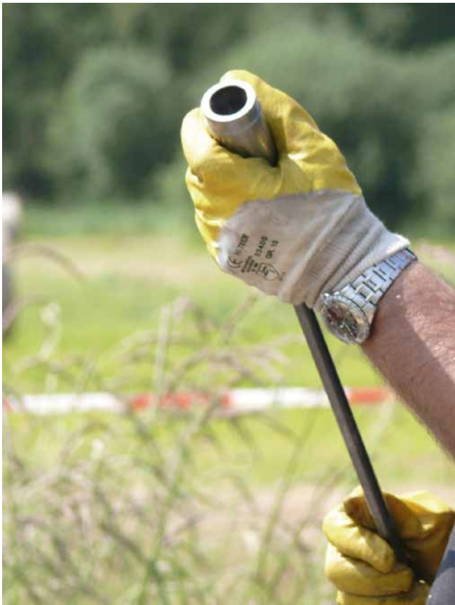
Montage der Rammverpresslanzen
