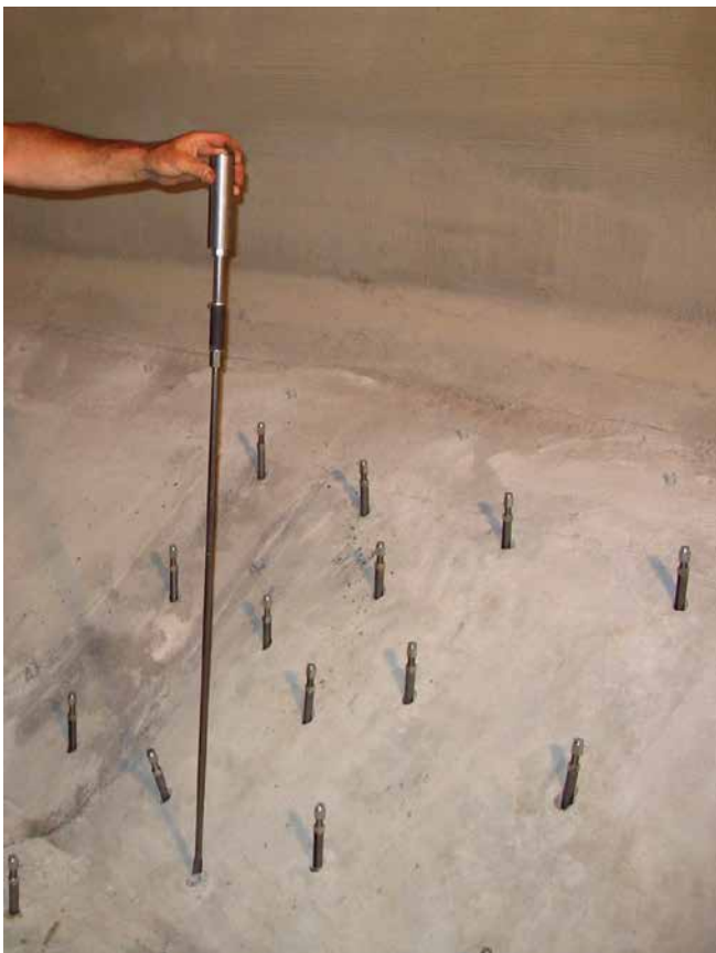
Gesetzte Rammverpresslanzen - Trinkwasserbehälter „Schwarze Pumpe“
