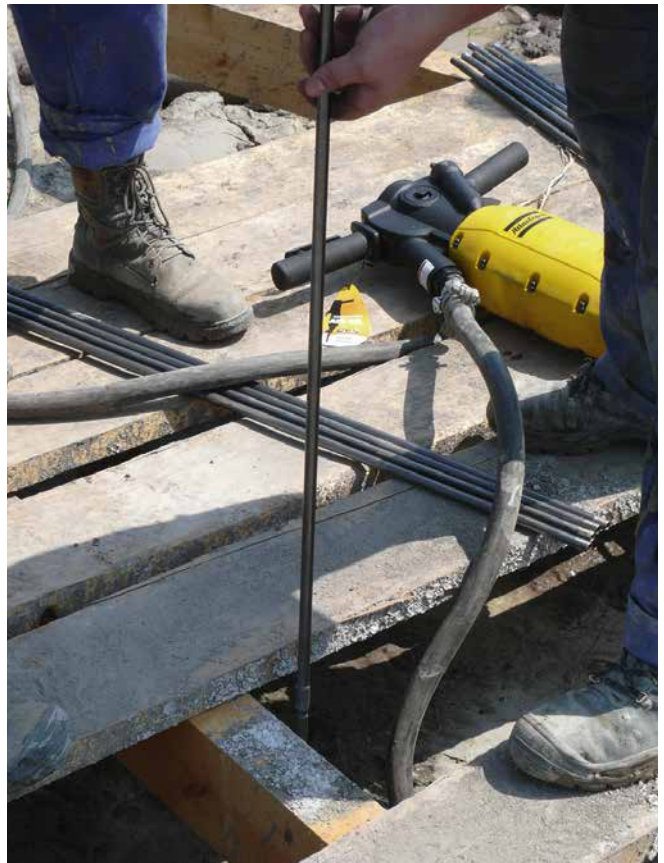
Einbringen der Rammverpresslanzen (Fotos: Desoi)
