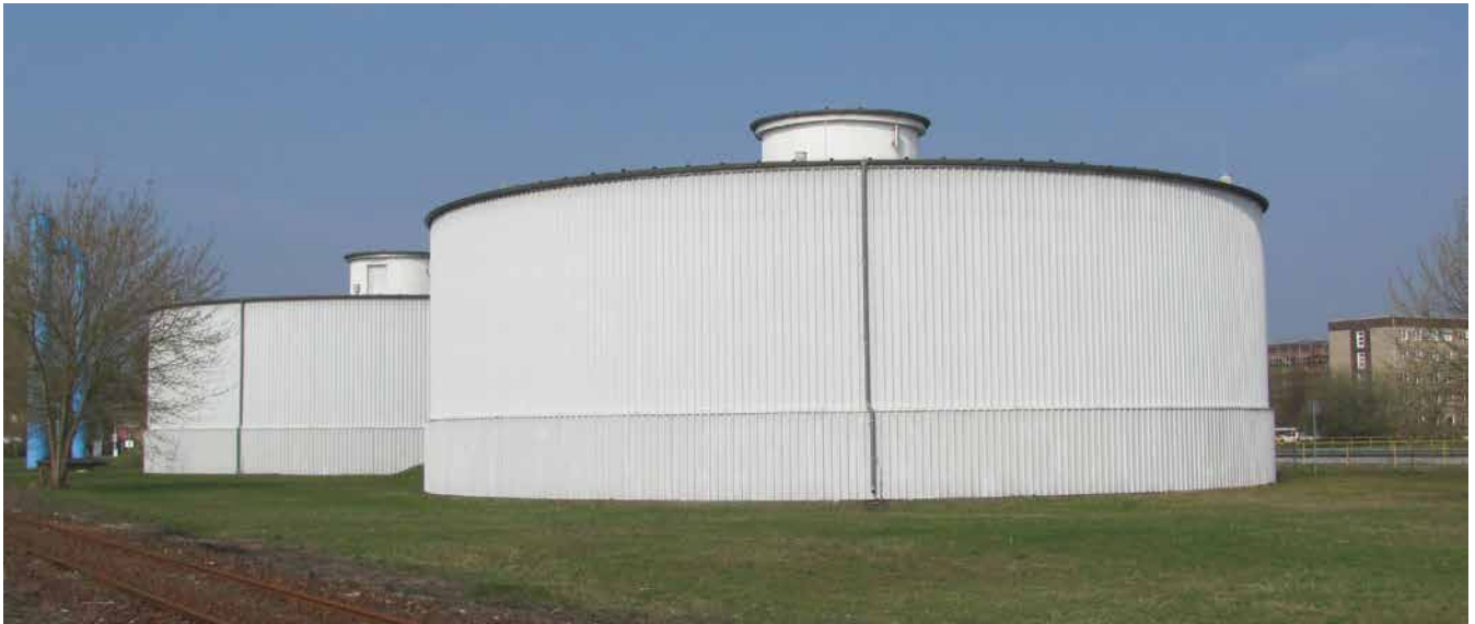
Trinkwasserbehälter „Schwarze Pumpe“
