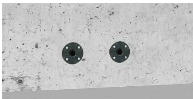
② Nagelpacker nach Entfernen der Schalung ② Injecteurs à clouer après l'enlèvement du coffrage
